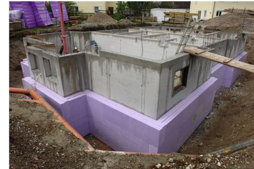
XPS - Perimeterdämmung
