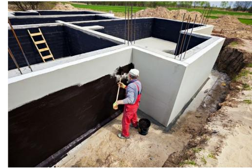
Bitumen - Flüssigabdichtung
