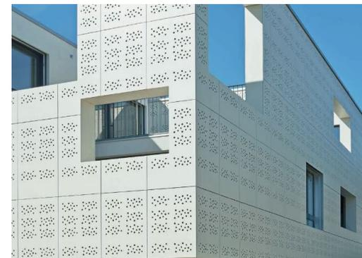
Faserzementplatten – Fassadendetails
