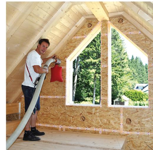
Holzfaser – Einblasdämmung
