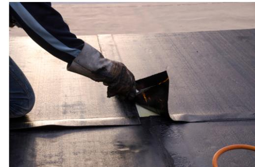
Bitumen – Montage mit Additiven
