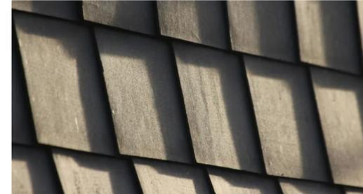
Faserzementplatten – Fassadendeckung
